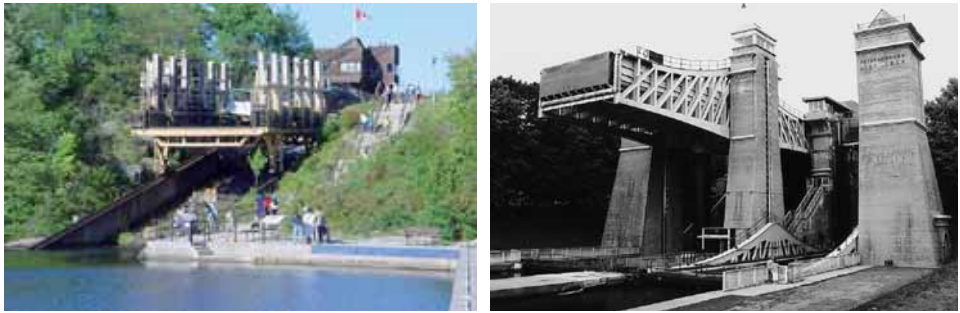
Fig. 18 - Differenti e originalissimi tipi di chiuse ottocentesche: a Big Chute con una ferrovia marina (n. 44), a Peterborough con un ascensore idraulico (n. 21)
