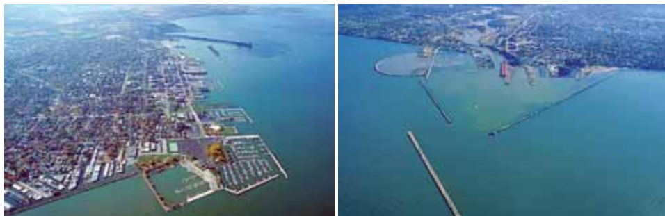
Fig. 42 - Ashtabula, evidenti i depositi di minerali ferrosi e carbone e il tracciato delle ferrovie che li servono. Conneaut, appariscenti le barriere frangiflutti che proteggono l'imboccatura; si distinguono le strutture per il traffico di minerali ferrosi e carbone in sponda destra, per pietrame e per la nautica da diporto in sponda sinistra (US Army Corps of Engineers)
