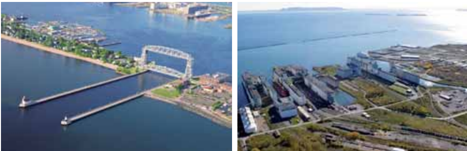
Fig. 32 - L'accesso al porto di Duluth (Aerial Bridge) e gli elevatori per cereali di Thunder Bay
