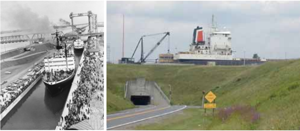
Fig. 25 - L'apertura della St Lawrence Seaway presso il St Lambert Lock nel 1959; il tunnel stradale della Barnhart Island Road realizzato 16 metri sotto l'Eisenhower Lock che si trova a 73 m s.l.m.
