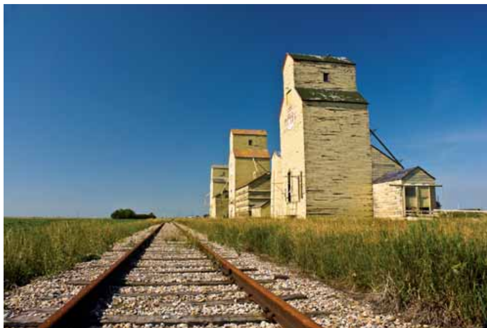
Fig. 50 - Manitoba: “sentinelle delle praterie”, storici sili cerealicoli muniti di elevatori lungo ferrovia per facilitare il carico del prodotto sui vagoni
