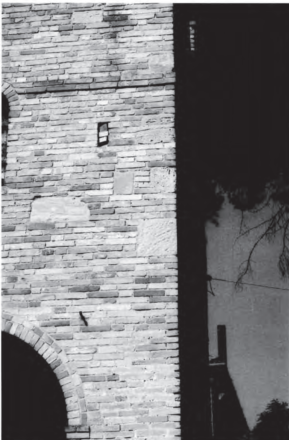
FERMO - Marina Palmense. Blocchi antichi riutilizzati nella torre dei Conti Garulli (foto E. Catani).
