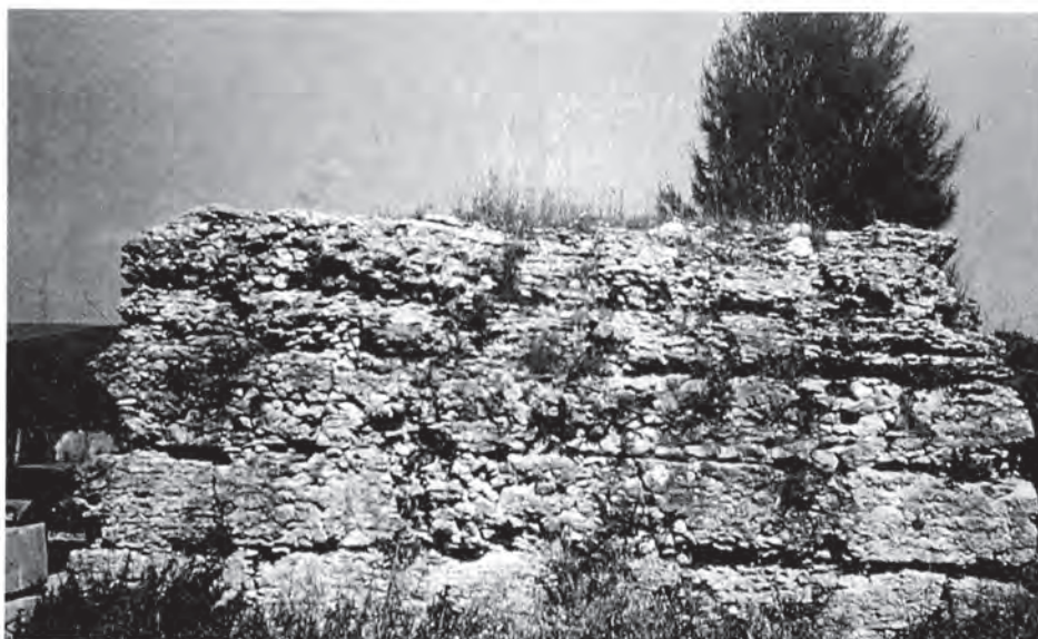
2. Contrada Salvano di Fermo. Il monumento funerario n. 1, ripreso da sud-ovest (foto E. Catani).
