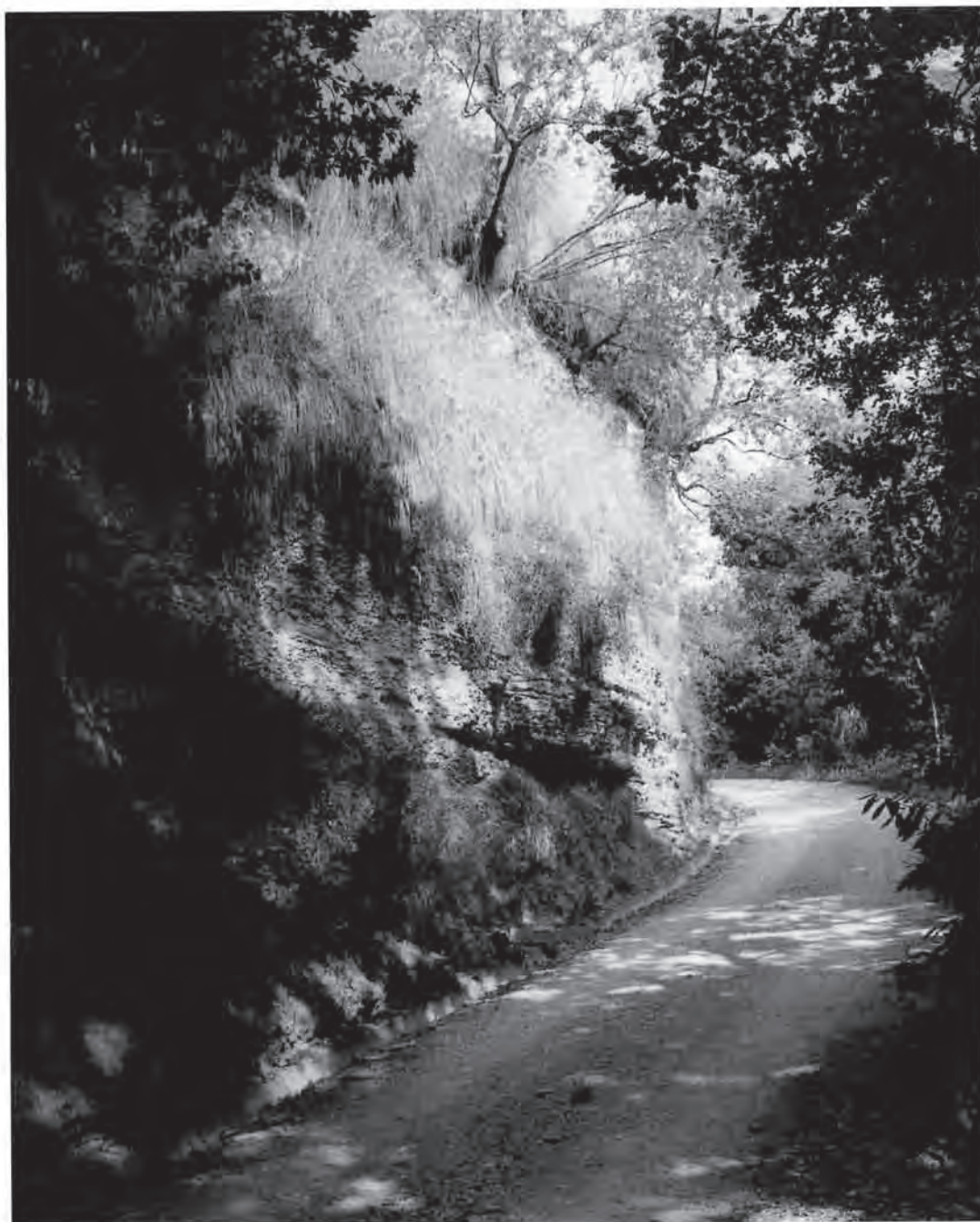
Torre di Palme - Contrada Cugnòlo. L'alta tagliata rocciosa della strada Comunale Cupa in prossimità di Villa degli Aranci (foto Catani).
