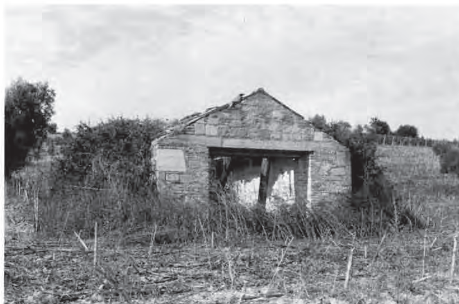
2. PORTO S. GIORGIO - Contrada S. Vittoria. Edificio rurale a quota 112 s.l.m. con antichi blocchi riutilizzati (foto E. Catani).
