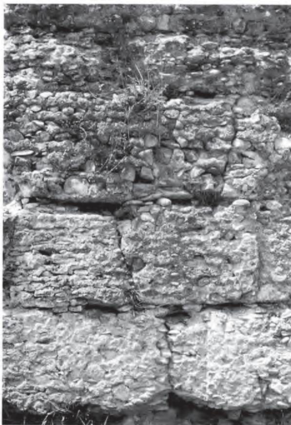
1. Contrada Salvano di Fermo. Particolare del nucleo cementizio del monumento funerario n. 1, con le impronte dei blocchi rivestimento (foto E. Catani).
