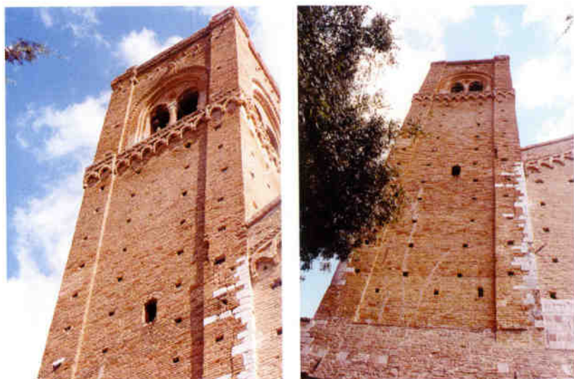
Figg. 1. e 2. La torre campanaria: visibile la scarpa muraria basamentale, e la bifora della cella campanaria realizzata in laterizio, probabile intervento ricostruttivo di V.E. Aleandri.
