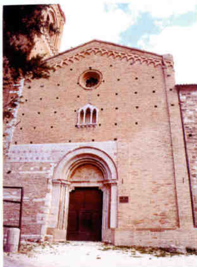
Fig. 4. Facciata: si noti la porzione di cortina muraria a destra del portale evidentemente diversa dalle porzioni limitrofe. Intervento ricostruttivo realizzato negli interventi condotto tra il 1896 ed il 1905.
