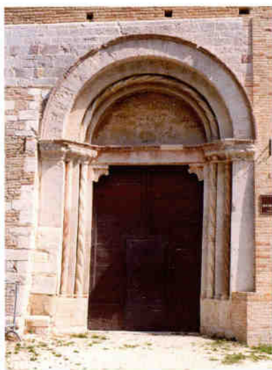
Fig. 5. Portale: colonnine tortili e ghiere dell'arco sono state oggetto di smontaggio e rimontaggio durante i lavori condotti da V.E. Aleandri e successivamente in concomitanza dei lavori effettuati dopo il 1926.
