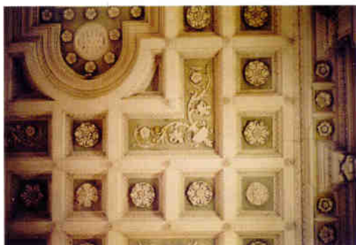
Fig. 6. Soffitto a lacunari: particolare del soffitto dell'aula.
