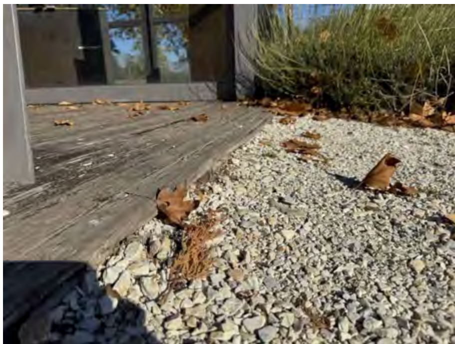
Figura 44 - Particolare della pedana di accesso alla biglietteria. Fonte: foto dell'autore
