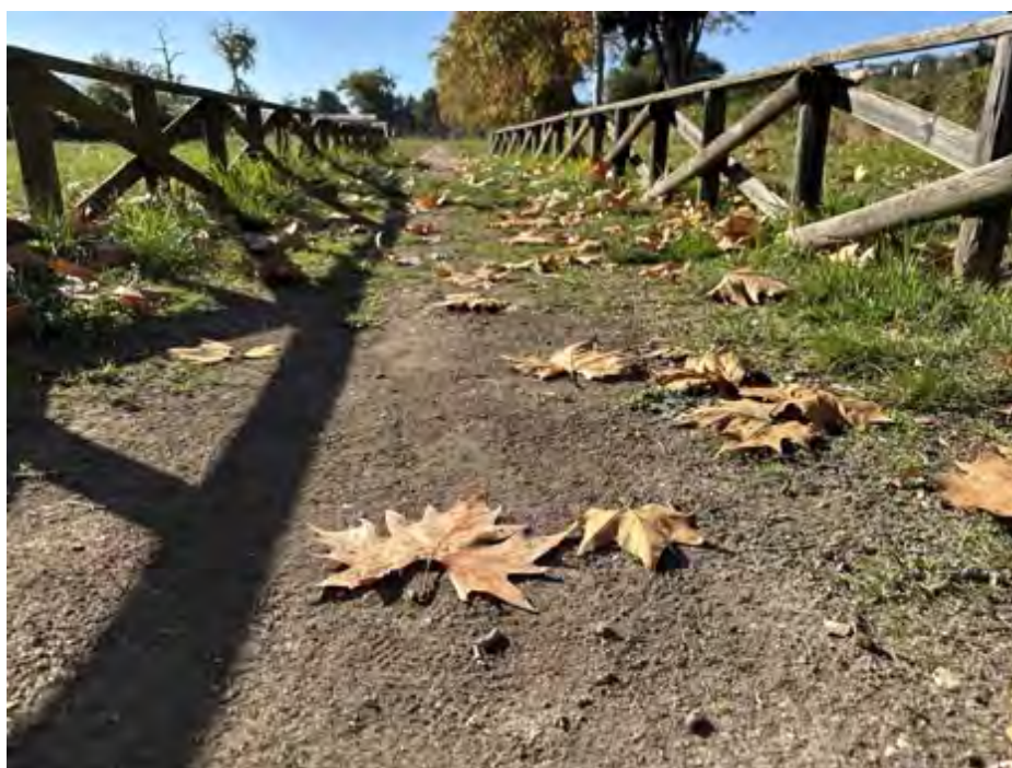
Figura 54- Tessitura del fondo in terra e ghiaia fine lungo il percorso verde, con buona stabilità e continuità. Fonte: foto dell'autore.
