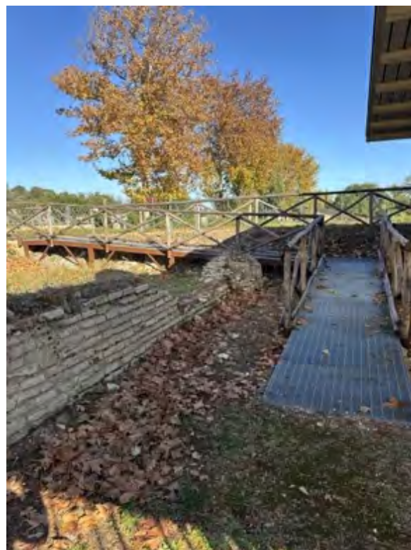
Figura 48 - La passerella che permette dal percorso verde di raggiungere l'interno dell'edificio del criptoportico. Fonte: foto dell'autore
