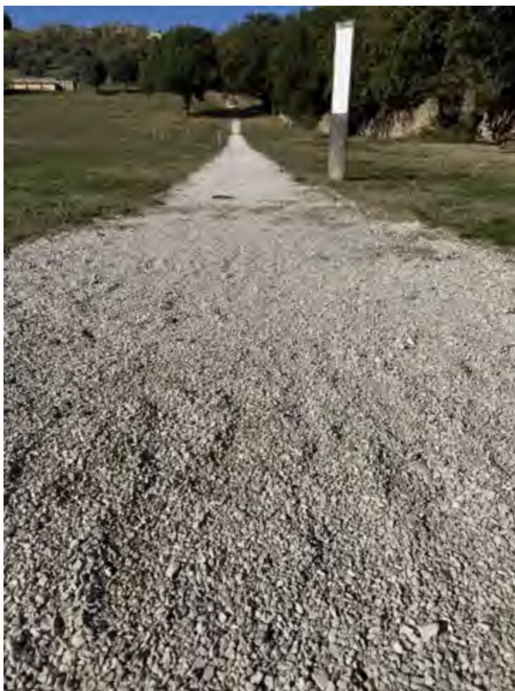
Figura 60 - Tratto iniziale del percorso blu dopo la passerella sopraelevata, con fondo in ghiaia e larghezza di circa 2 metri. Fonte: foto dell'autore.
