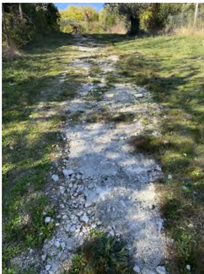
Figura 63 - Segmento del percorso blu con fondo disomogeneo e presenza di pietre naturali affioranti. Fonte: foto dell'autore.
