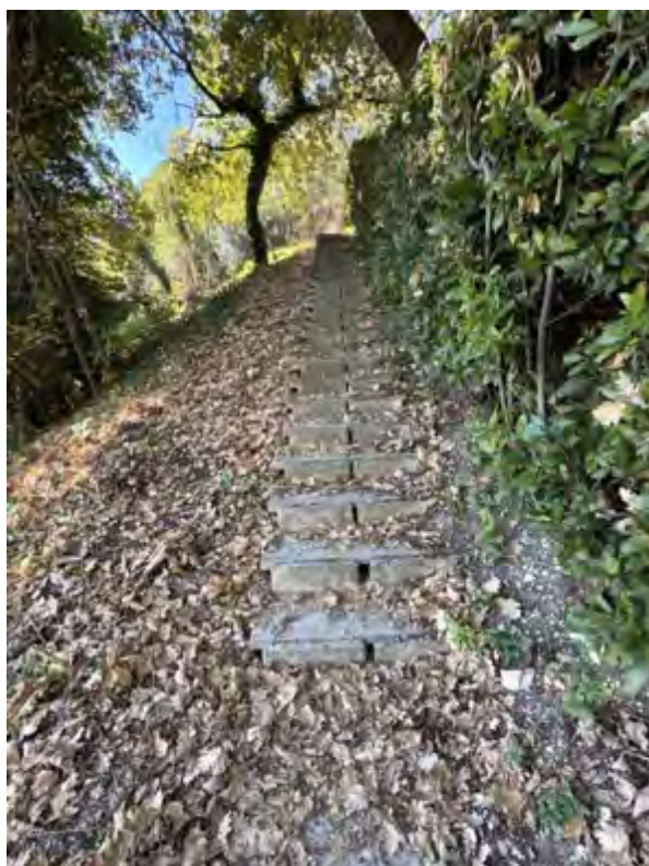
Figura 34- Particolare della prima parte della gradinata che dai percorsi blu/rosso, conduce al serbatoio romano. Fonte: foto dell'autore
