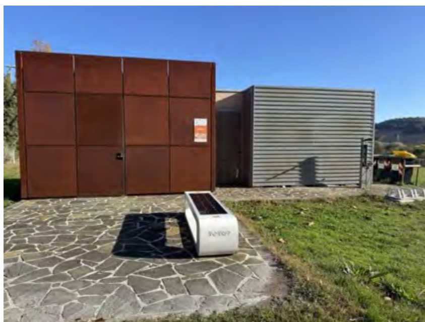
Figura 93 - Blocco dei servizi nella zona del parcheggio. Fonte: foto dell'autore.
