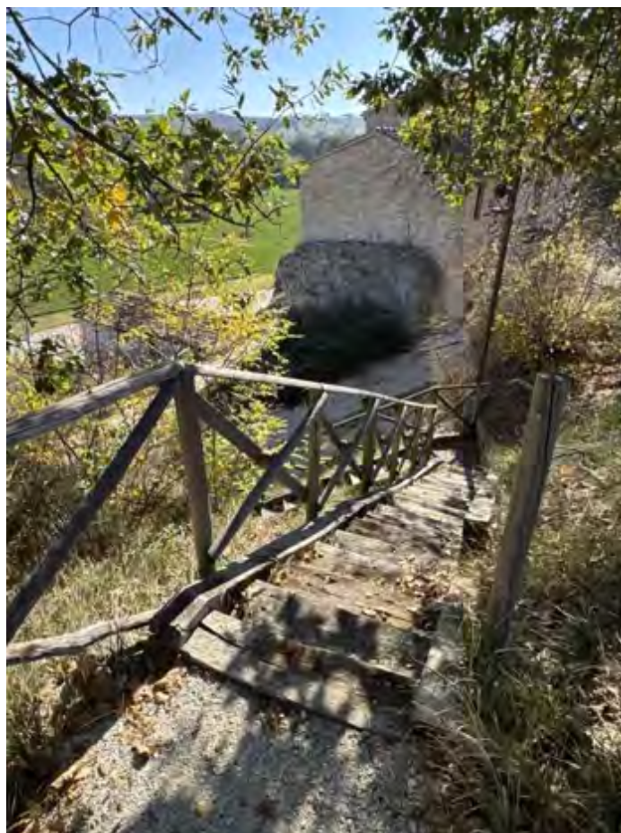
Figura 49 - Scalinata che collega Porta Gemina al percorso verde. Fonte: foto dell'autore.
