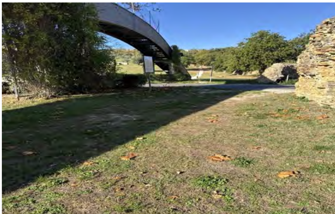
Figura 96 - Panoramica del punto dove installare l'attraversamento a chiamata. Fonte: foto dell'autore.
