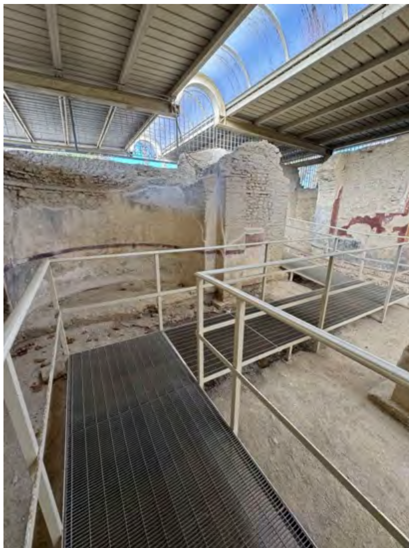
Figura 82 - Particolare della passerella metallica che permette la visita agli affreschi e alle architetture del criptoportico. Fonte: foto dell'autore.
