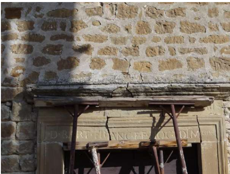
Figura 7 - Il Santuario di Garufo post sisma (fonte studio Bocci and Partners s.r.l.) - danni all'iscrizione sul portale (facciata)
