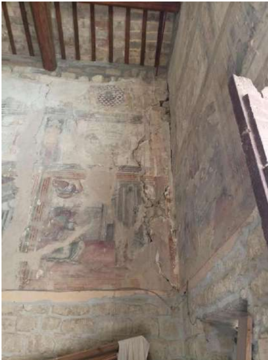
Figura 11 - Il Santuario di Garufo post sisma (fonte studio Bocci and Partners s.r.l.) - danni agli affreschi (interno)
