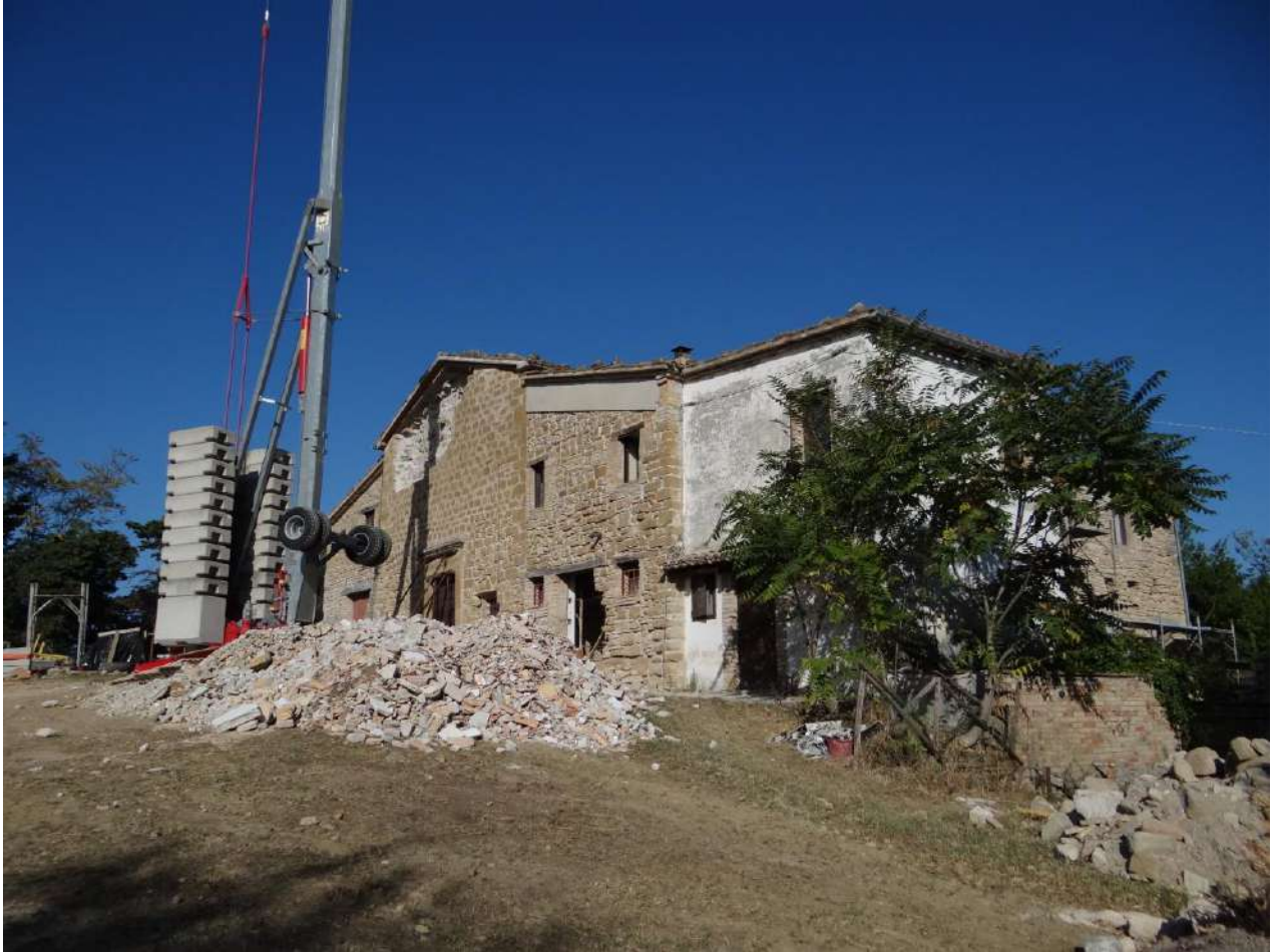
Figura 50 – Santuario di Garufo. Inizio lavori, esterno
