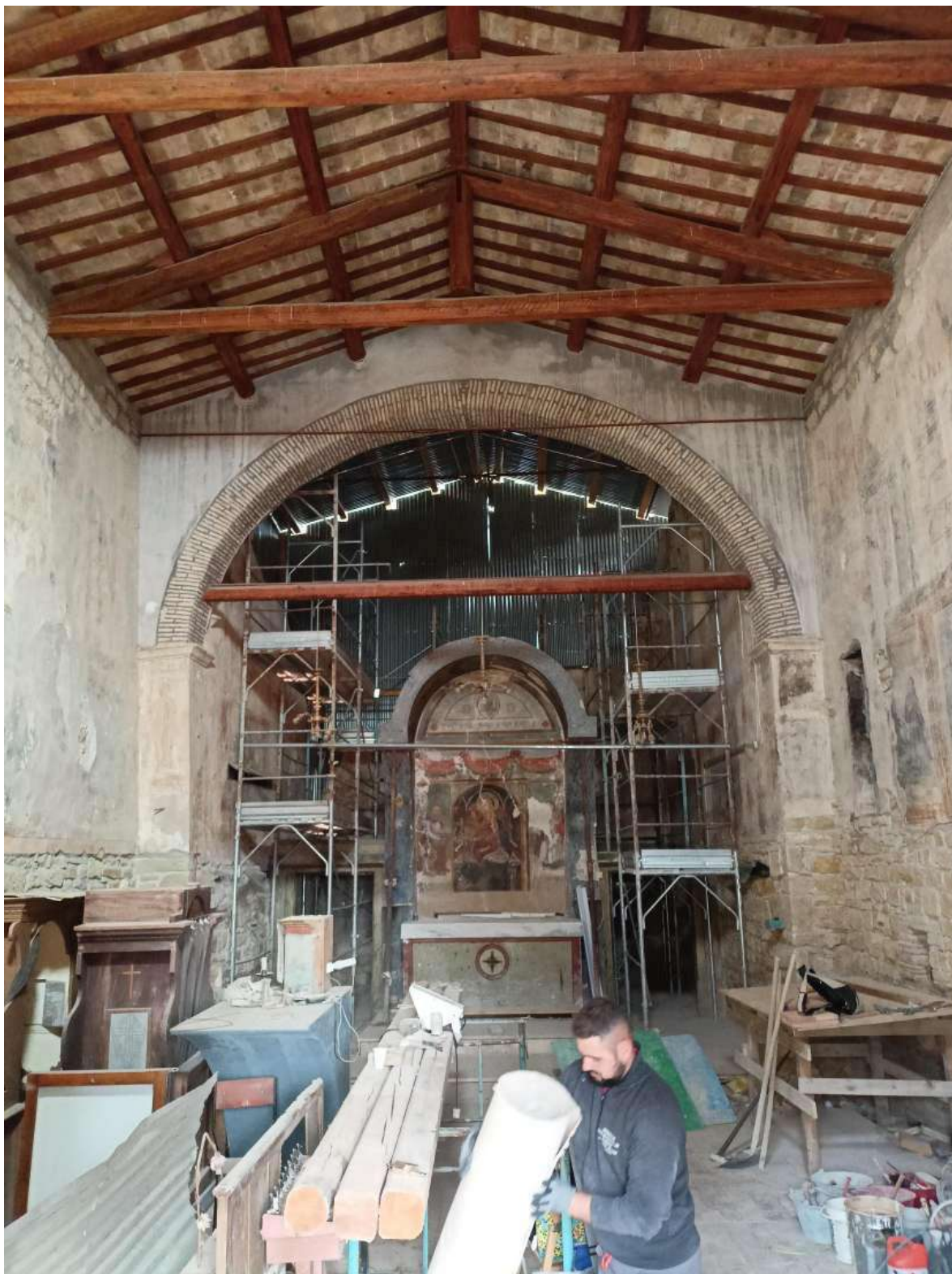
Figura 51 – Santuario di Garufo. Inizio lavori, interno
