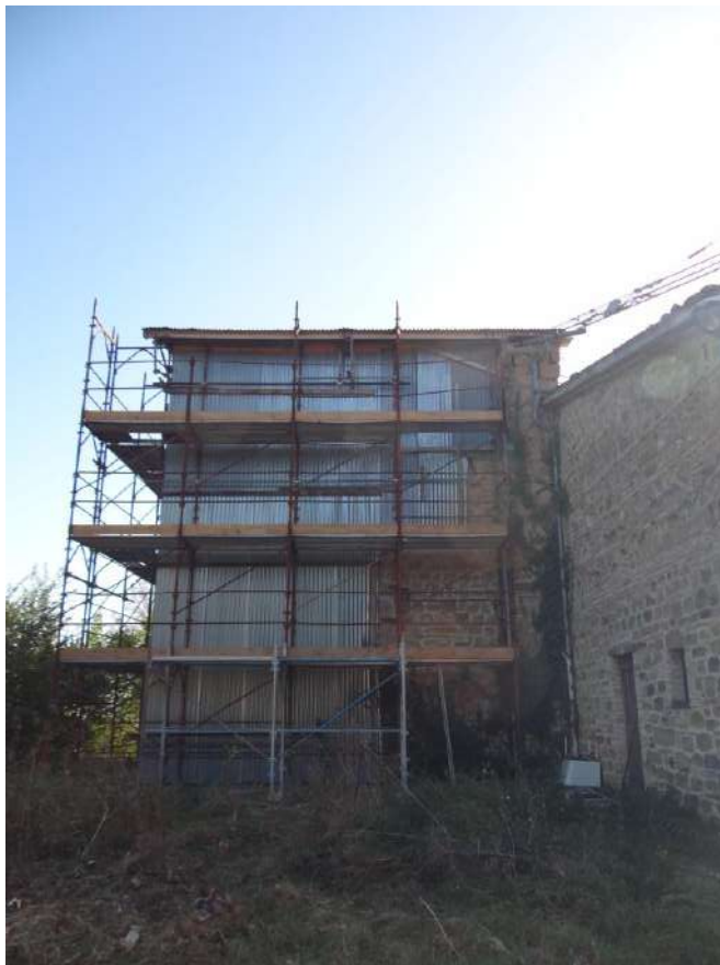
Figura 9 - Il Santuario di Garufo post sisma (fonte studio Bocci and Partners s.r.l.) - dettaglio danni a tetto e abside, parete laterale sx
