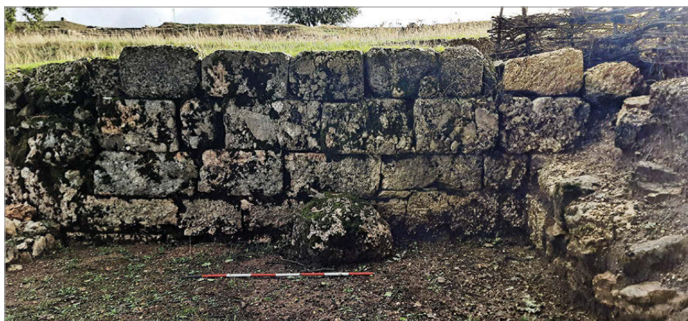
fig. 5. Muro in opera quadrata.
