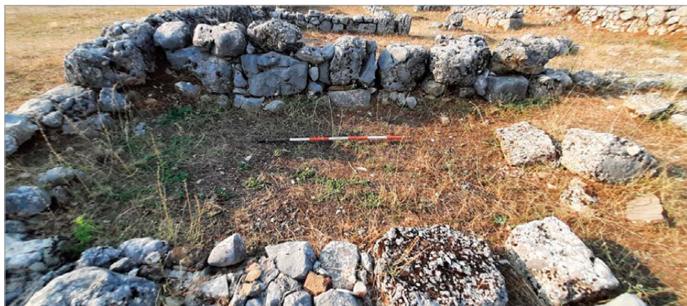
fig. 6. Muro in opera sbazzata con pietre di medie e grandi dimensioni.
