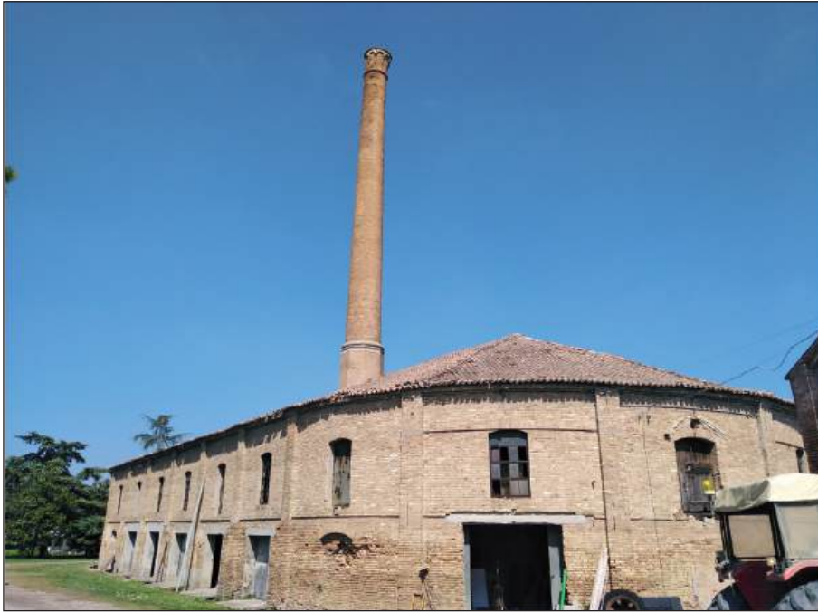
Fig. 2 - Fornace di tipo Hoffman da tempo non più in funzione ed oggi destinata a ricovero per attrezzature di una azienda agricola a Cavarella Po (Rovigo)
