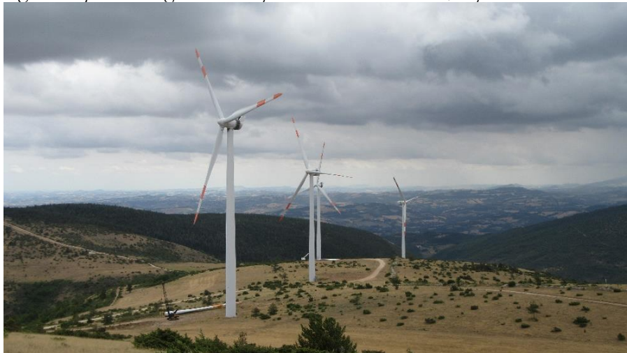
Fig. 1 – I quattro aerogeneratori del parco eolico Monte d’Aria, in provincia di Macerata
