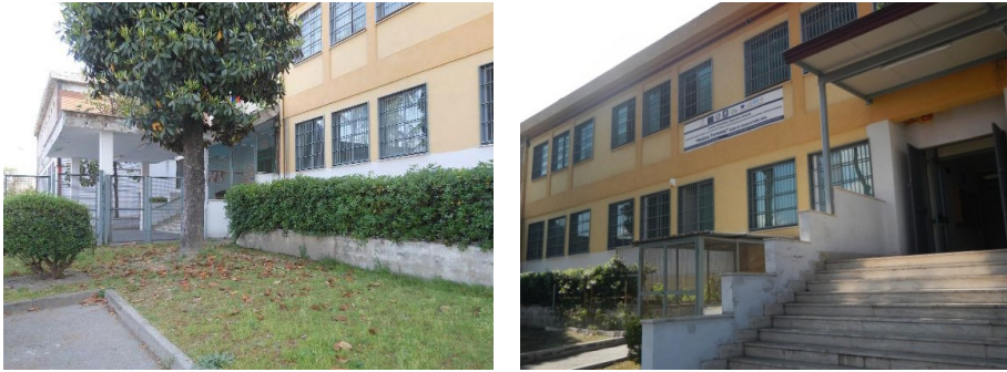
Fig. 1 - La facciata d'ingresso dell'Istituto scolastico
