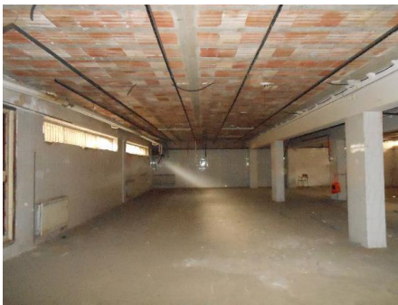
Fig. 2 - Veduta dell'ambiente seminterrato
