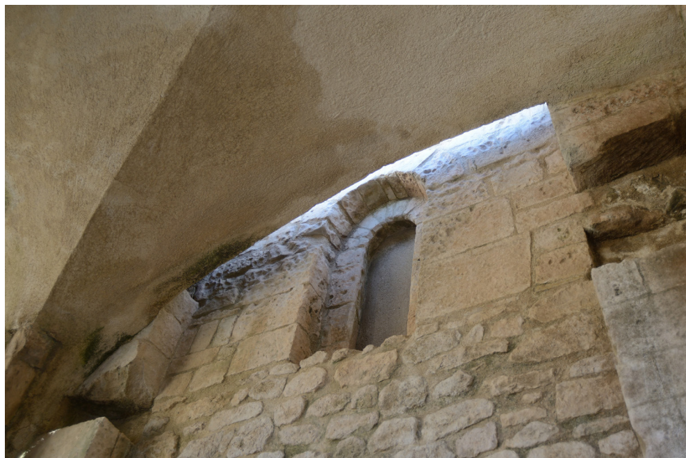
Fig. 6. S. Maria di Tremiti, perimetrale esterno settentrionale dell'abbaziale, fascia inferiore, monofora (foto Autore)
