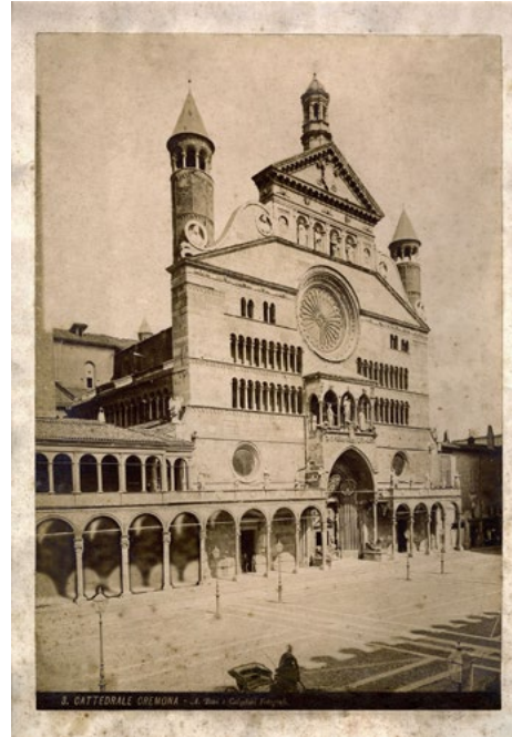
Figura 5 - Restauro virtuale della fotografia della Cattedrale di Cremona.
