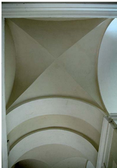
Fig. 23. Palazzo De Sanctis, scalone monumentale, sistema voltato del pianerottolo
