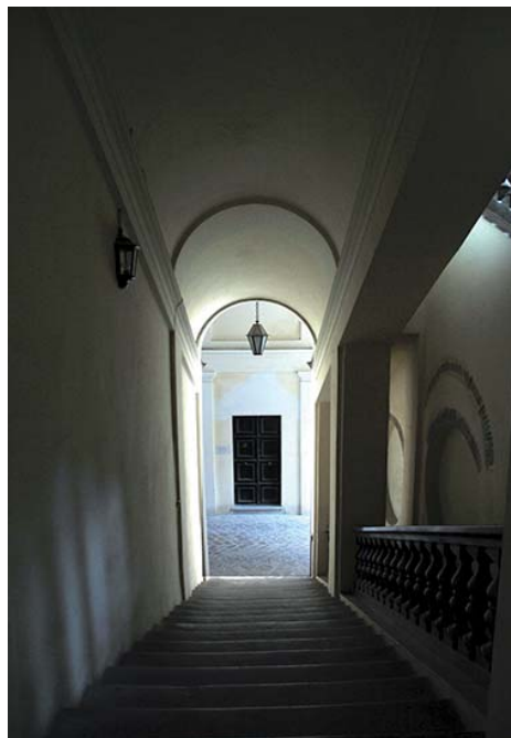
Fig. 24 Palazzo De Sanctis, scalone monumentale, visibili gli archi tamponati sotto la seconda rampa
