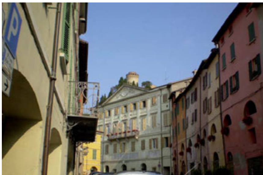
Fig. 2. Facciata del Palazzo Comunale di Brisighella (foto F. Fabbi).
