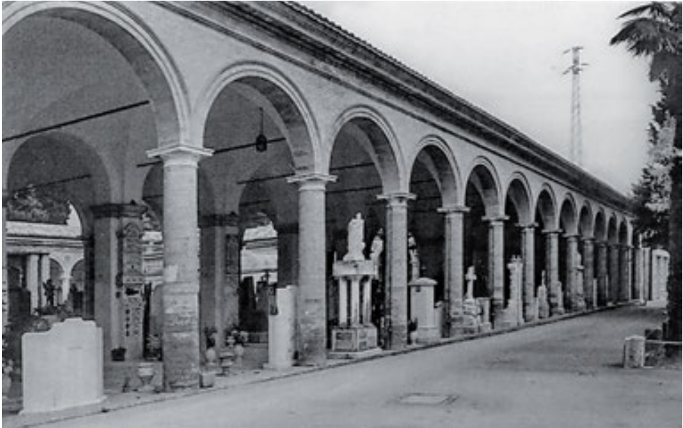
Fig. 6. Macerata, portico del Cimitero comunale, ing. Vincenzo Berenzi e arch. Antonio Mollari, 1813
