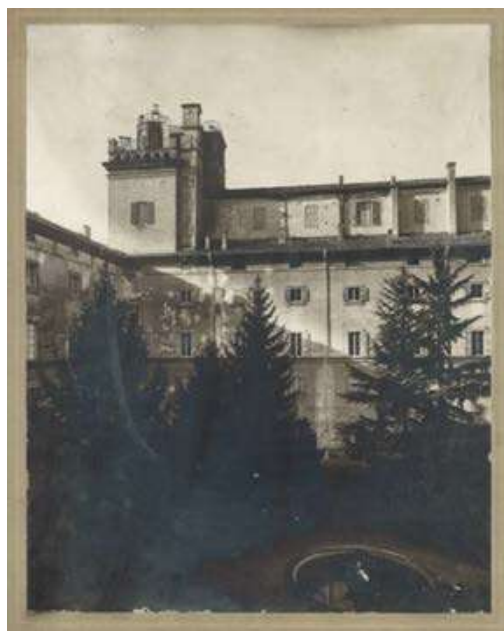
Fig. 1. La torretta dell’Osservatorio vista dal cortile interno del Convento di San Rocco, sede dell’Università di Parma. L’immagine, conservato all’Osservatorio, è successiva ai lavori di restauro del 1933. Risultano visibili la saletta barometrica ottagonale e la cabina termometrica di forma rettangolare, nella parte Nord del fabbricato.
