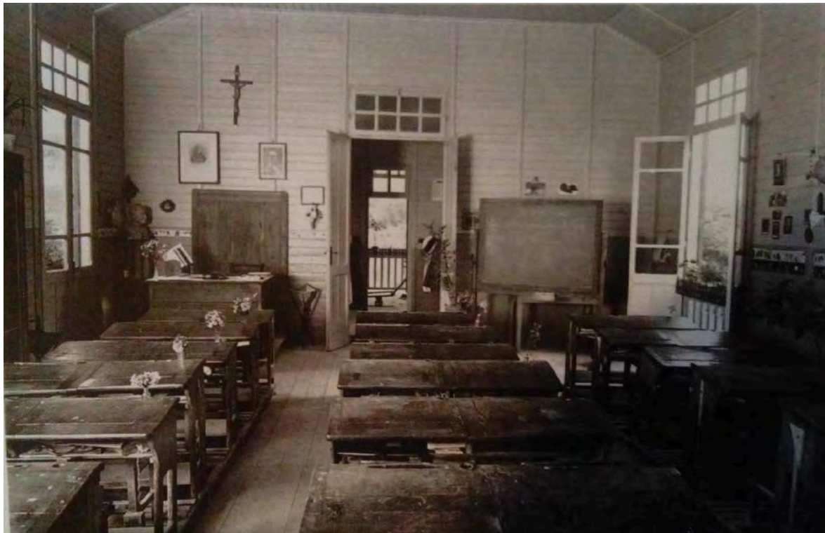
Figura 7 Interno della scuola all'aperto di Macerata
