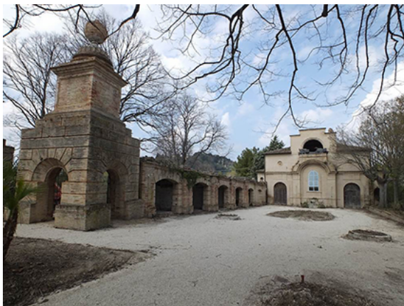
Fig. 4: i propilei, il sistema delle serre e il fronte sud della casa del giardiniere; http://www.iluoghidelsilenzio.it/villa-spada-la-quiete-treia-mc/
