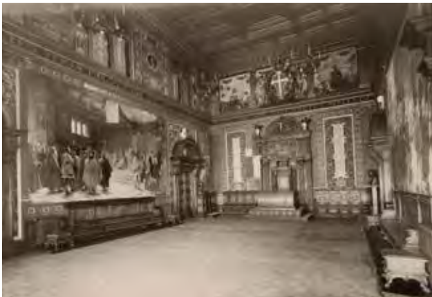
L'Aula Magna prima del restauro intervenuto negli anni '60 del Novecento
