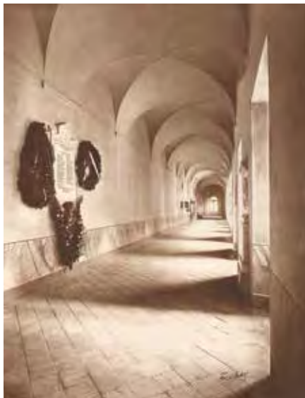
Palazzo dell'Università, sede del Dipartimento di Giurisprudenza, corridoio d'ingresso, oggi e negli anni '20
