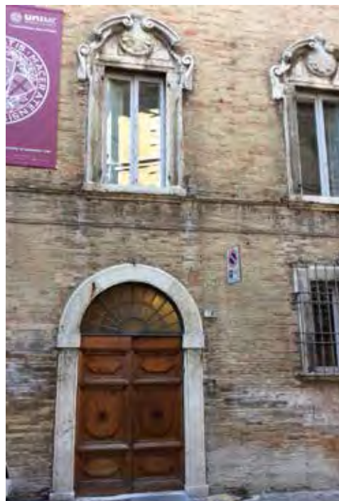
Palazzo Chiappini in via Crescimbeni, altra sede del Dipartimento di Economia e diritto
