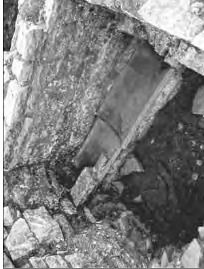
Fig. 222. - Laterizi: tegole piane rialzate in una canaletta.
