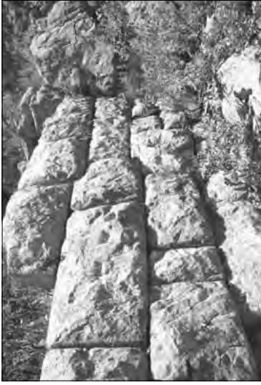
Fig. 55 - Selo, paramento esterno di una delle torri, in grandi blocchi calcarei disposti in opera rettangolare.
