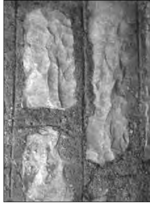
Fig. 265. - USM 2053, particolare della stilatura.
