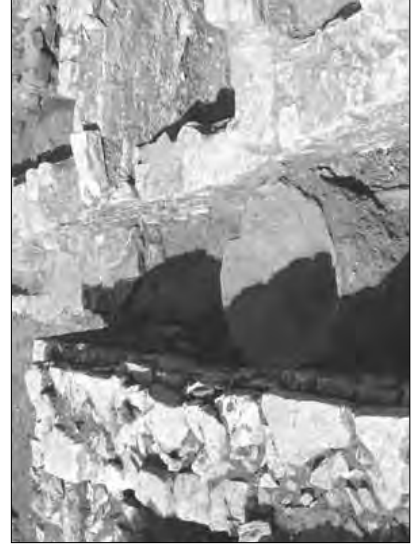
Fig. 136. - Sistema di canalizzazione realizzato con tubuli in piombo.
