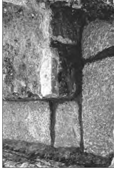
Fig. 115. - Il muro 2010 dell'Edificio con funzioni termali.
