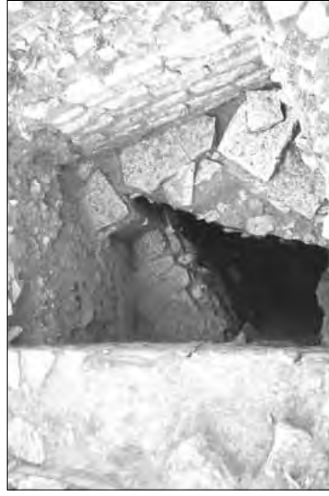
Fig. 98. - Prosecuzione verso Ovest della canaletta in Fig. 97.
