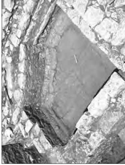
Fig. 135. - Vaschetta con pavimento rivestito di laterizio a Sud.
