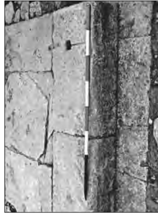
Fig. 263. - Opera quadrata utilizzata ad Hadrianopolis.
