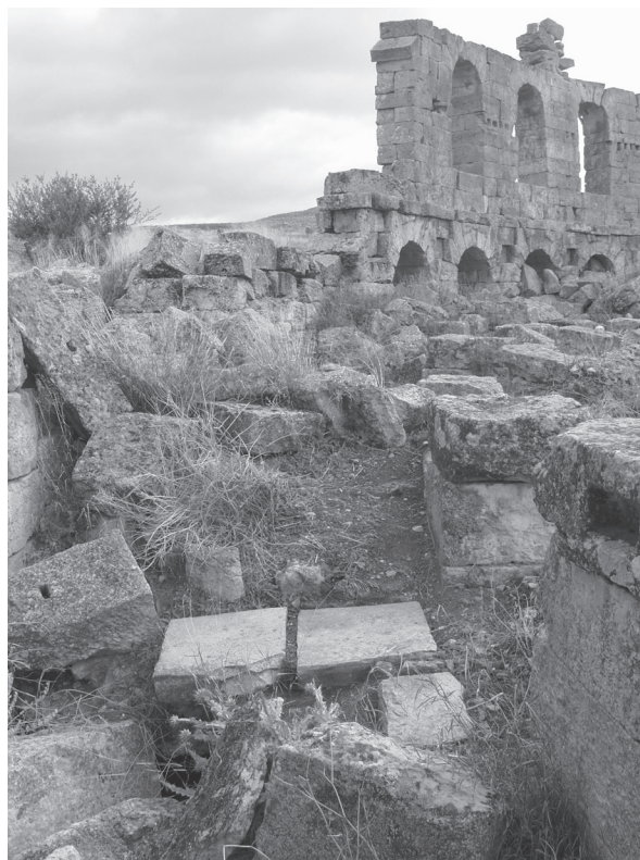
Fig. 11 – ALTHIBUROS, TEATRO. L'ambulacro esterno del II ordine, lastre della pavimentazione in corrispondenza del pilone 13, da Ovest.
