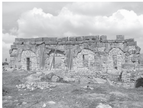
Fig. 9 – ALTHIBUROS, TEATRO. Resti del II ordine del muro perimetrale della cavea, interno, piloni 9.II.a - 13.II.a, da Sud.
