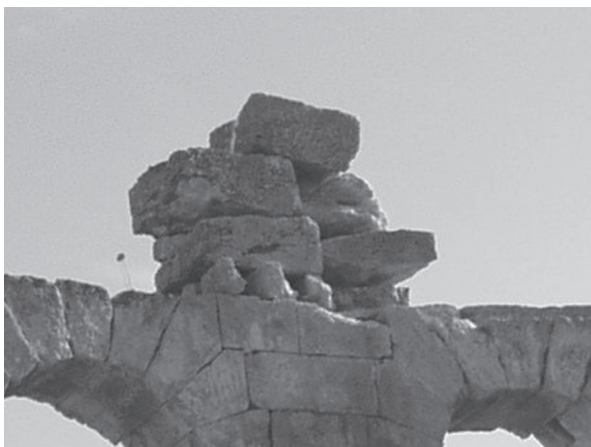
Fig. 6 – ALTHIBUROS, TEATRO. Muro d'attico, elementi con incassi per le travi lignee, parete interna, da Ovest.
