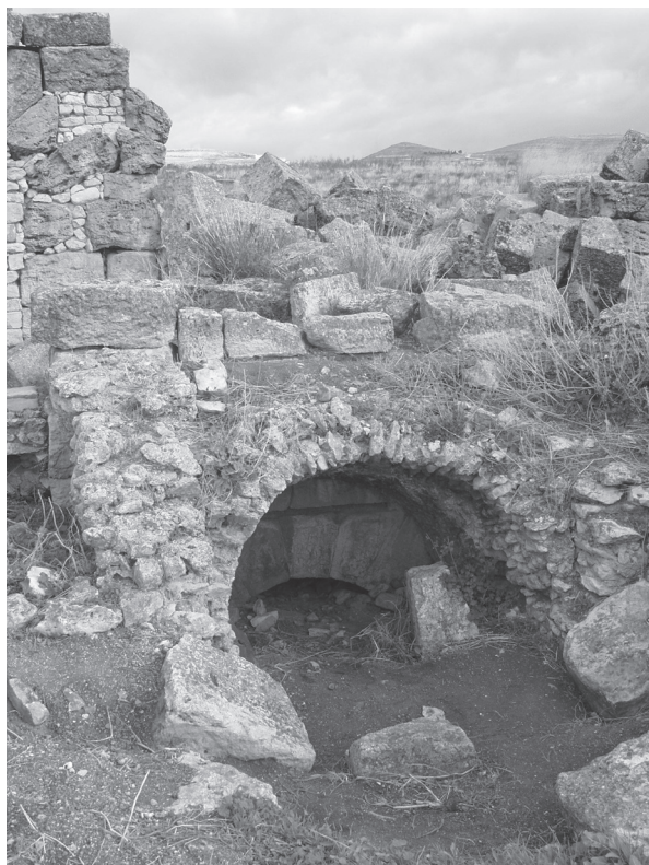
Fig. 10 – ALTHIBUROS, TEATRO. Resti del corridoio voltato radiale sull'asse del teatro, in corrispondenza dell'arcata 13, vomitorium, da Sud.
