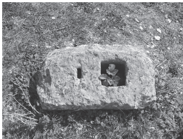
Fig. 7 – ALTHIBUROS, TEATRO. Mensola con foro passante per il velarium .
