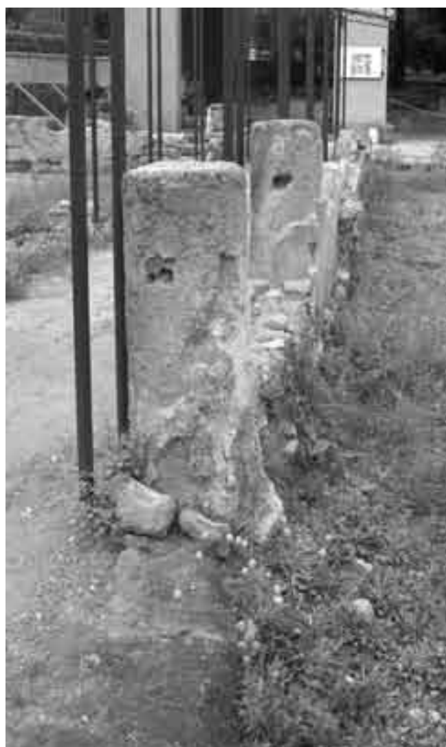
FIG. 26. Palermo, Piazza della Vittoria, Edificio B. Portico occidentale del peristilio: fusti di colonna con incassi per elementi lignei, da Sud.
