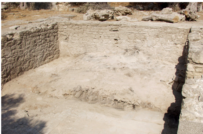
Fig. 14 - Gortina. Edificio Sud. Vano 53: veduta dello strato di distruzione sul pavimento dell'ambiente, a seguito del crollo della copertura. Da Nord-Est.
