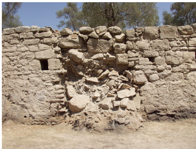
Fig. 12 - Gortina. Edificio Sud. Vano 53: l'apertura praticata nel muro Nord dell'ambiente. Da Sud.
