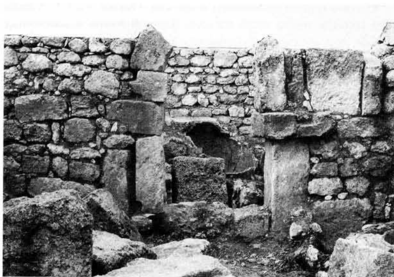
Fig. 12 - SIRET EL GIAMEL. L'ingresso alla cella vinaria 9, visto da Sud, dopo la parziale demolizione della tamponatura inferiore (neg. M.I.C., A81/17/17).
