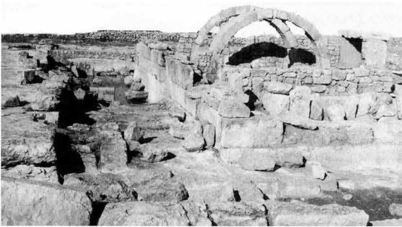
Fig. 6 - SIRET EL GIAMEL. Il laboratorio vinicolo ripreso da Sud-Ovest, dopo l'anastilosi delle arcate interne (neg. M.I.C., B72/4/4).
