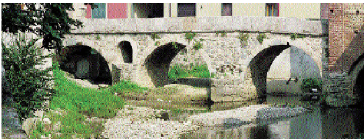
Veduta del ponte da sud, dopo i restauri del 2002.
