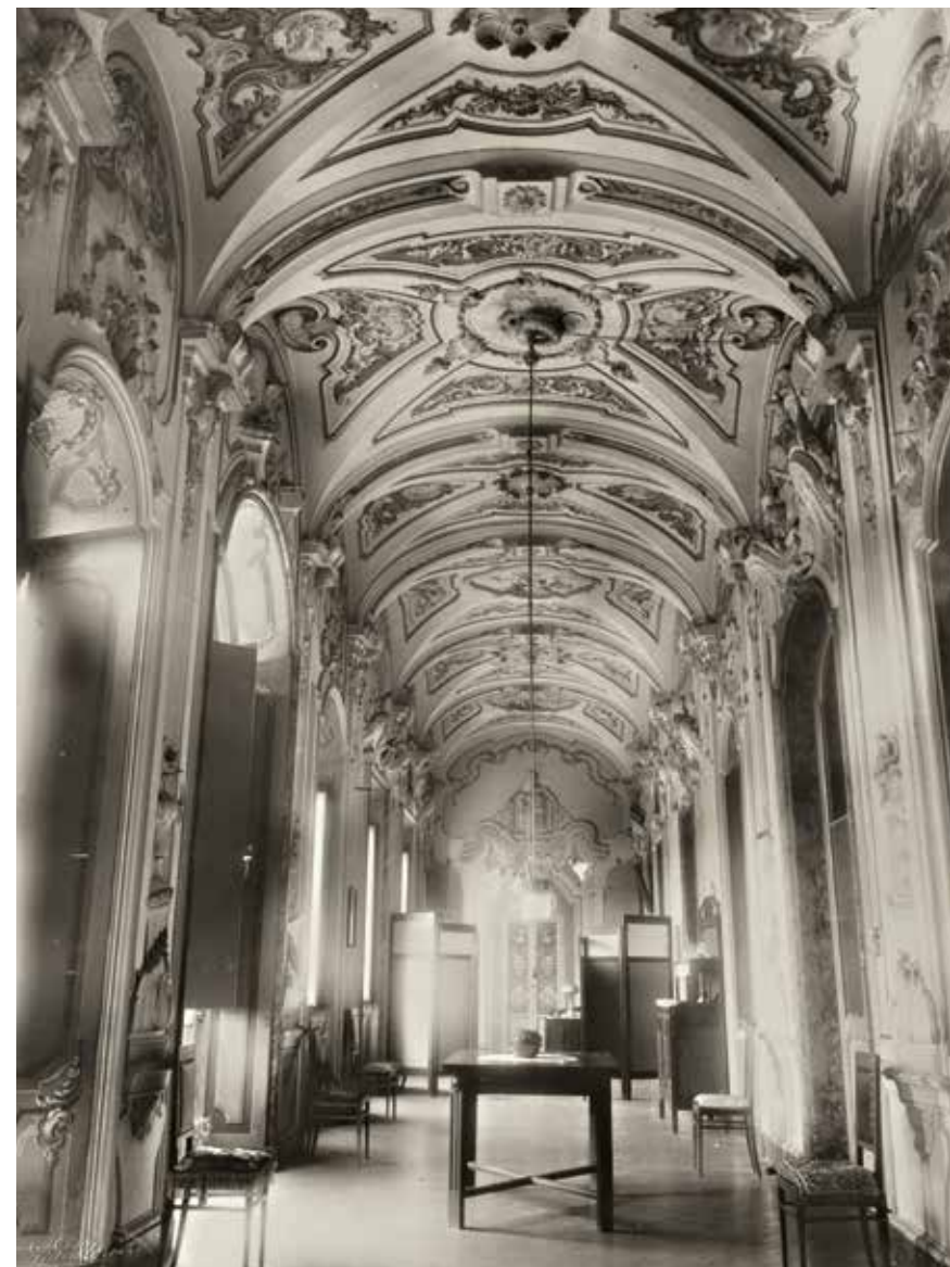
Galleria degli Stucchi, Palazzo Pianetti Tesei, Jesi (AN).
