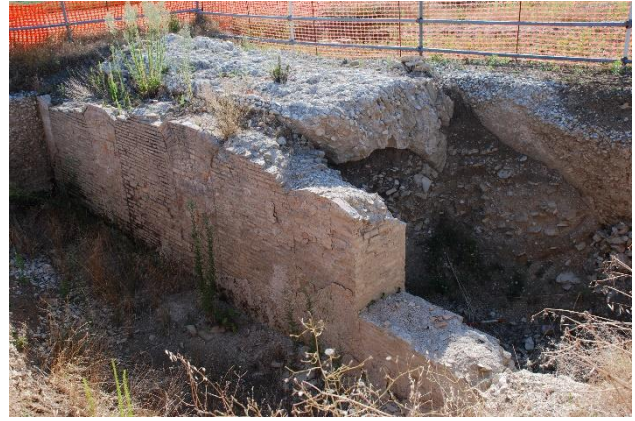
Figura 16 - La cisterna interrata a seguito della rimozione degli strati che la riempivano (foto CAL 2007).
