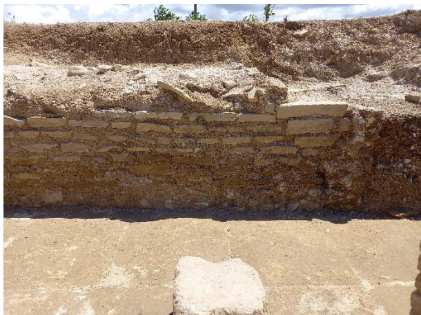
Figura 28 - Dal basso: fondazioni USM 1060; muro USM 1061; muro USM 1042. Sulla destra si noti il taglio US -1064 e la spalletta USM 1063 del Periodo 3 – Fase B.
