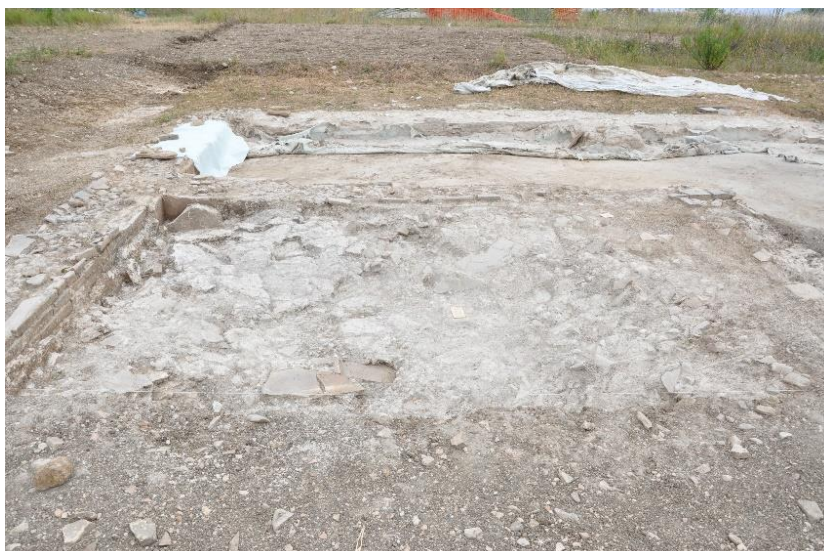
Figura 20 - Crollo delle pareti all'interno dell'A2.
