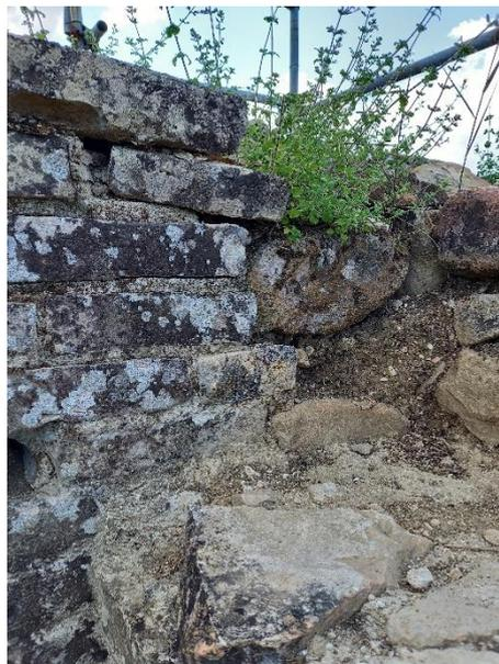
*Figura 13 - Particolare del punto di aggancio tra la parete della cantina (USM 4154) e il muro USM 4039, distrutto per costruire la prima.*
