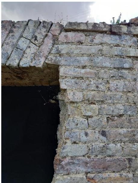
*Figura 12 - Particolare della piattabanda e della parete di accesso alla cantina voltata (USM 4154).*
