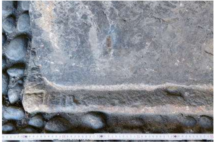
Fig. 8. Arcovolo 53 interno, parete sinistra: tracciato di cantiere sulla superficie del plinto del pilastro, inserito nella platea, per il corretto posizionamento del piedritto dell'architrave che introduce alla galleria minore.
