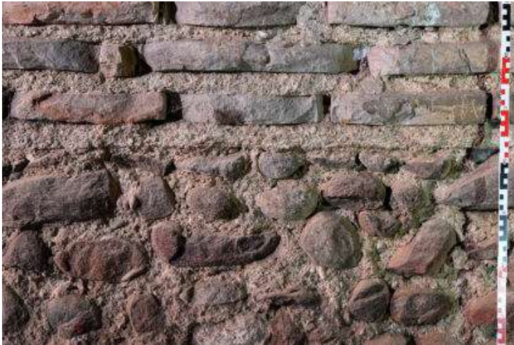
Fig. 10. Arcovolo 66 esterno, dettaglio della pausa e ripresa di cantiere tra muratura in ciottoli e fascia in mattoni.
