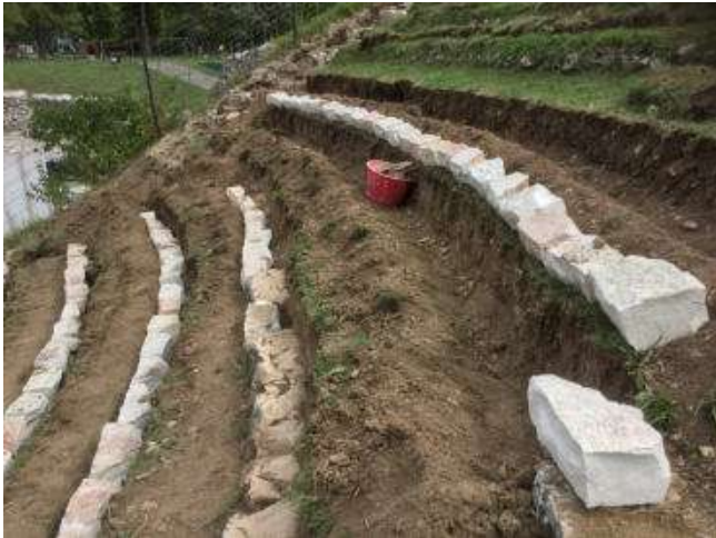
Fig. 2. Dettaglio dei recenti lavori di restauro presso il teatro romano di Gubbio.
