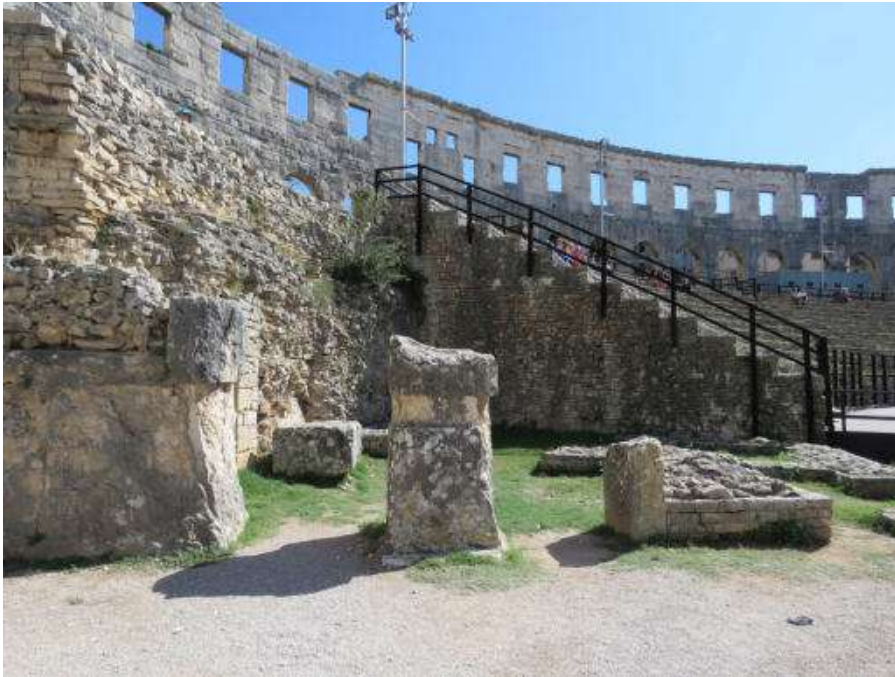
Fig. 9. Anfiteatro. Spazio che ospitava le sedute per gli spettatori. Elementi in grandi blocchi di pietra con strutture murarie in piccoli blocchi legati assieme da malta di calce e il riempimento a sacco con pietrame misto. Sono visibili i fori realizzati nella pietra per ospitare le travi in legno del corridoio del secondo piano (foto autore).
