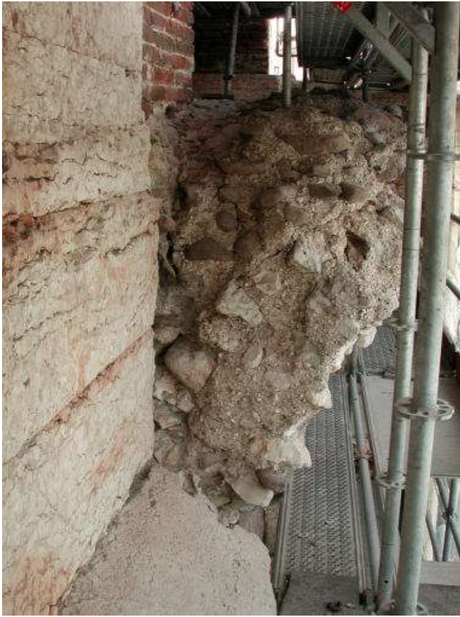
Fig. 11. Galleria esterna, arco 63: il moncone rimasto della volta che copriva il I ordine della galleria, formato dalla sovrapposizione di due diversi strati.
