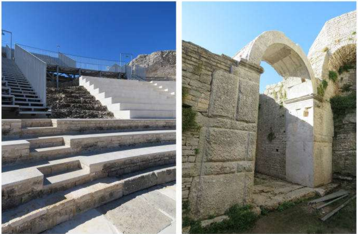
Fig. 8. Teatro romano minore. Dettaglio del taglio a gradinate nella roccia di fondo del monte, rimasto visibile in seguito alla ricostruzione della forma originale delle sedute e del portale d'ingresso nord. Gli elementi del portale sono eseguiti in grandi blocchi di pietra ben lavorata, connessa a secco con grappe in ferro, mentre le murature delle restanti strutture sono in elementi di pietra più piccoli, ben squadrate, legati tra loro con malta di calce (foto autore).
