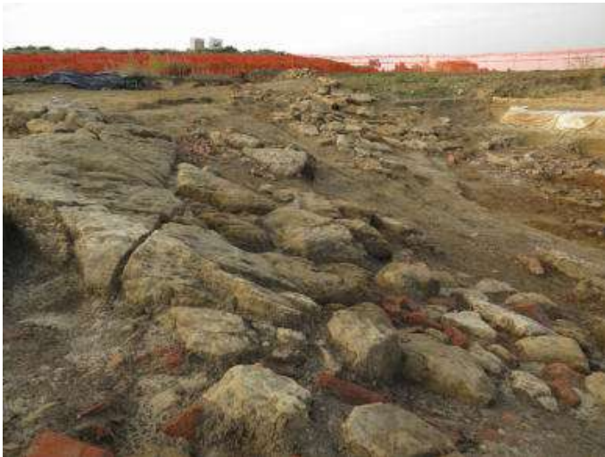
Fig. 11. Vista delle gradinate della cavea (foto M. Palmieri).
