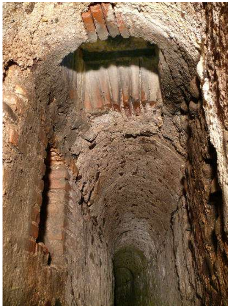
Fig. 5. Cunicolo esterno, quadrante II: in alto, il tombino in laterizi costruito nella volta a botte in ciottoli e malta; a sinistra, l'inizio del condotto costruito nella platea, con fianchi e fondo in laterizi e copertura in lastre, che scaricava qui l'acqua proveniente dalla struttura in elevato dell'anfiteatro.
