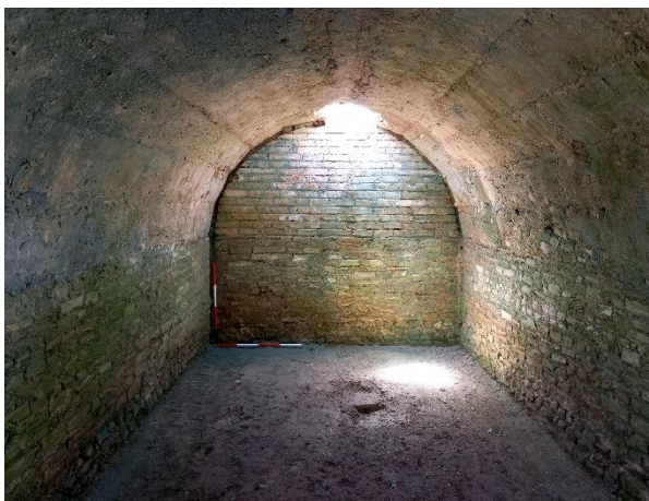
Figura 27 - La cantina voltata dopo la pulizia del 2021. Si notino le tracce delle travi impiegate per mettere in opera la volta.
