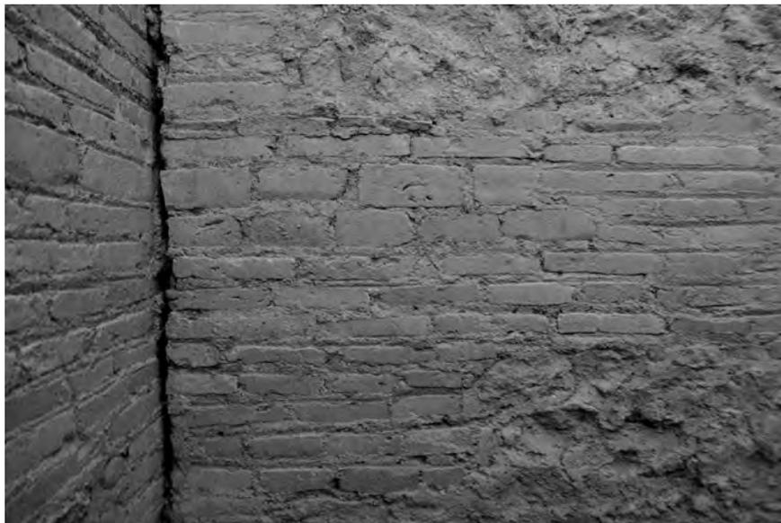
Fig. 9 – Particolare del paramento Ovest della struttura della cella: sulla destra la sarcitura di consolidamento che invade la catena orizzontale in laterizi, da Ovest (Foto Autore).
