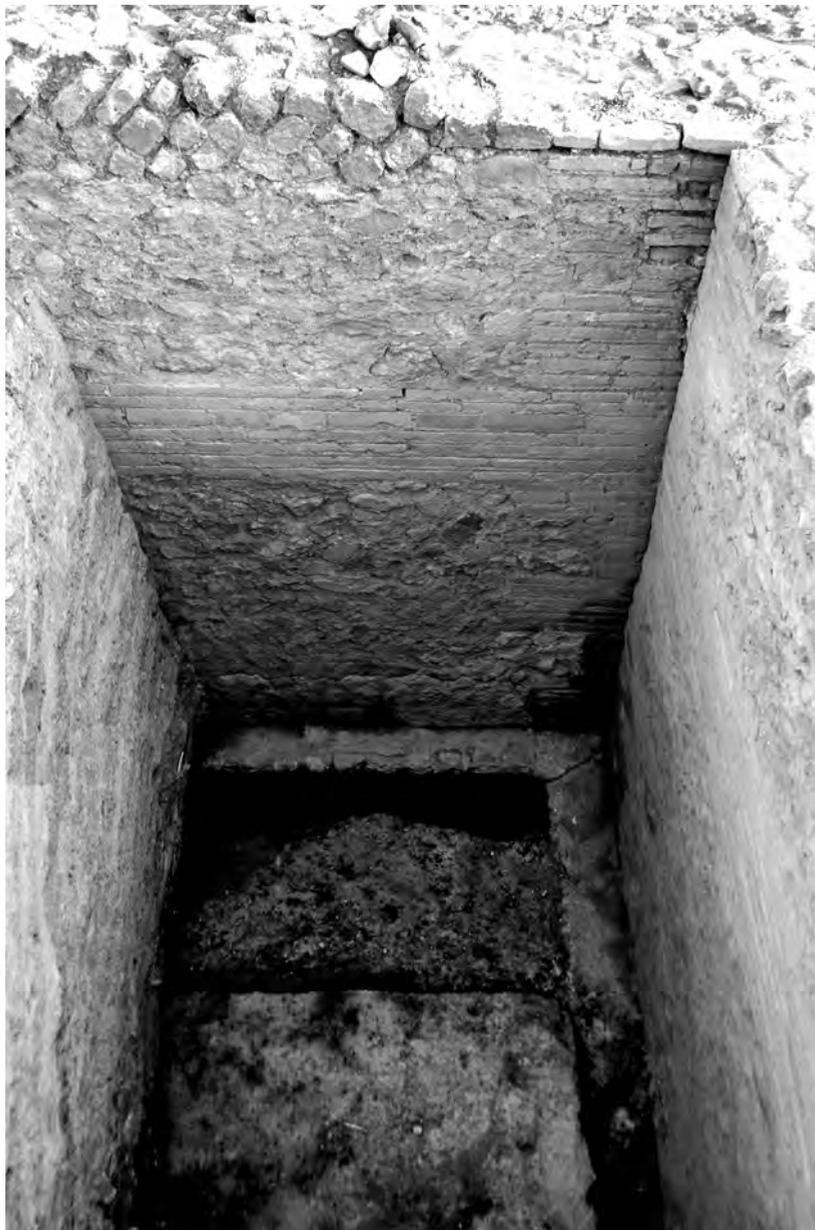
Fig. 7 – Il paramento interno del podio con la catena orizzontale in laterizi inserita tra le porzioni in opera cementizia. Sulla destra la sarcitura in laterizi che si ammorsa nelle strutture precedenti, da Sud (Foto Autore).
