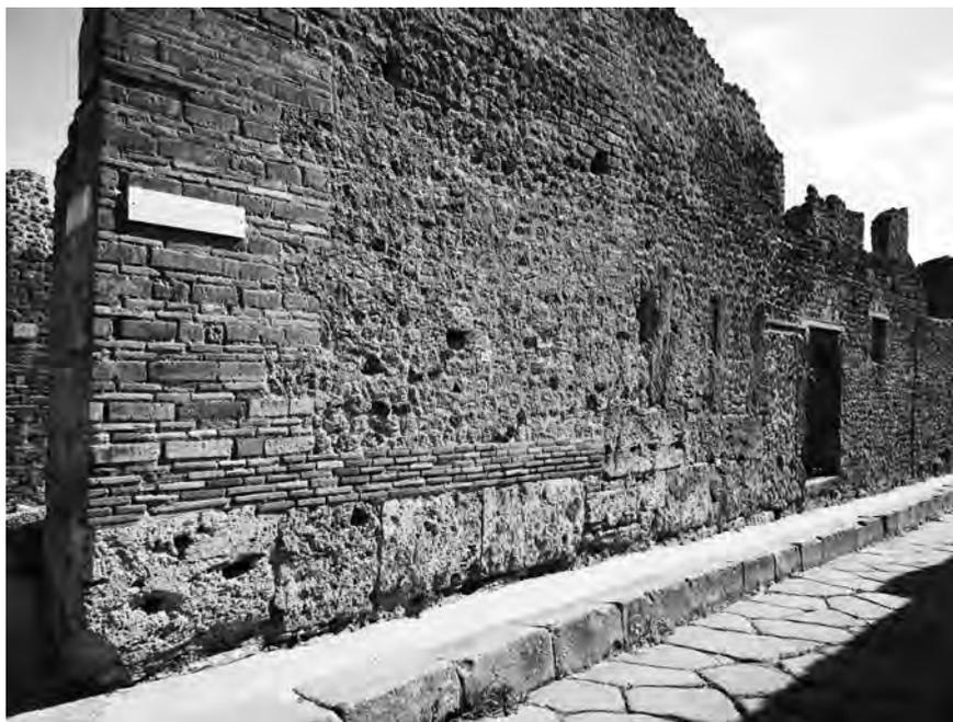
Fig. 30 – Pompei, vicolo di Tesmo (IX 7), interventi di restauro post-sismico (foto M. Giglio).
