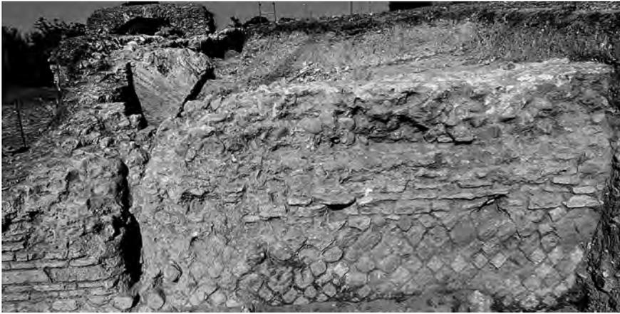
Fig. 17 – Paramento esterno della struttura muraria di delimitazione occidentale del podio (US 818), con i tre momenti costruttivi (opera reticolata inferiore, catena mediana di laterizi e nucleo in cementizio superiore), con arco in laterizi alle spalle (US 807), nella porzione interna e ciottoli dell'angolo Nord-Ovest del podio (Foto Autore).
