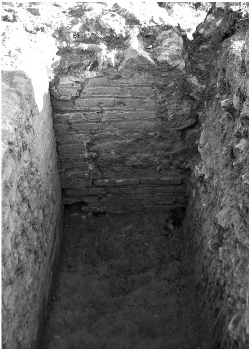
Fig. 8 – Il paramento interno del podio ad Est della struttura della cella: in alto parte della sarcitura; in basso i primi quattro filari della catena orizzontale in laterizi. Sulla sinistra si segnala la crepa con andamento verticale, da Sud (Foto Autore).
