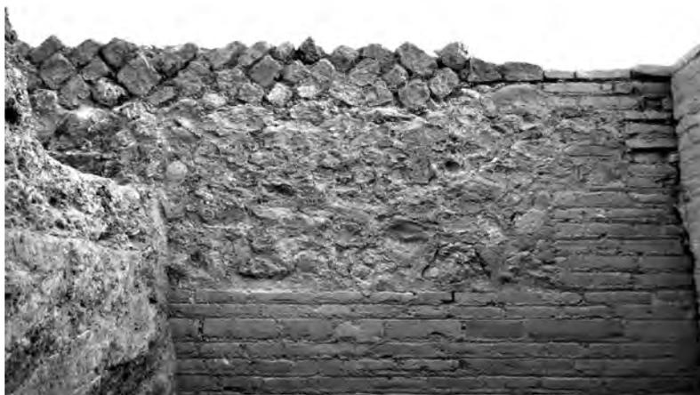
Fig. 6 – Particolare del paramento interno del podio: in alto i tre filari in opera reticolata riferibili alla prima fase di costruzione del tempio. In basso la catena orizzontale in laterizi in cui si segnala l'altezza anomala del terzo filare rispetto ai restanti. Sulla destra la parte superiore della sarcitura, da Sud (Foto Autore).
