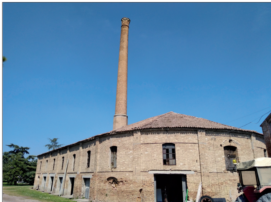
Fig. 2 - Fornace di tipo Hoffman da tempo non più in funzione ed oggi destinata a ricovero per attrezzature di una azienda agricola a Cavanella Po (Rovigo)
