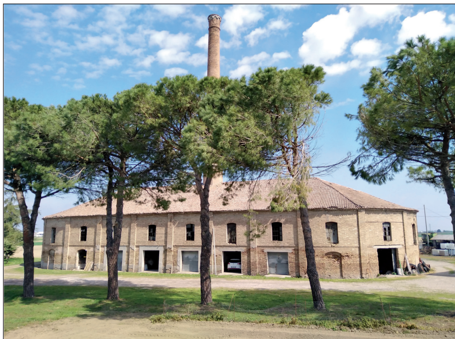
Fig. 4 - Fornace di tipo Hoffman di Cavanella Po. È evidente l'ampia struttura a carapace ellittico con la ciminiera al suo centro
