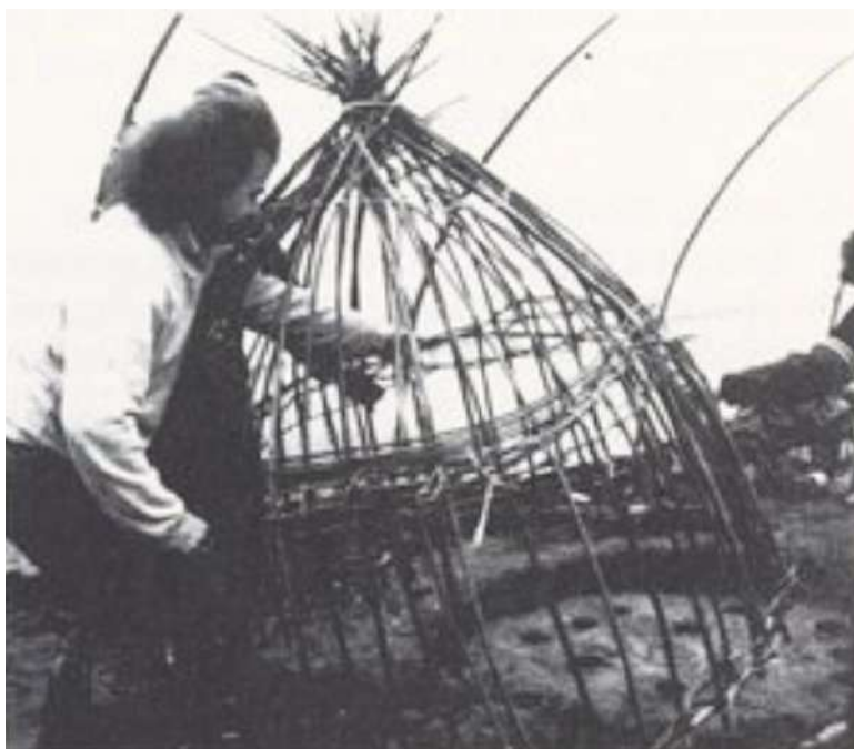
Figura 37 Costruzione della copertura della fornace sperimentale nel sito Gallo-Romano di Bliesbruck (Greff 1990)
