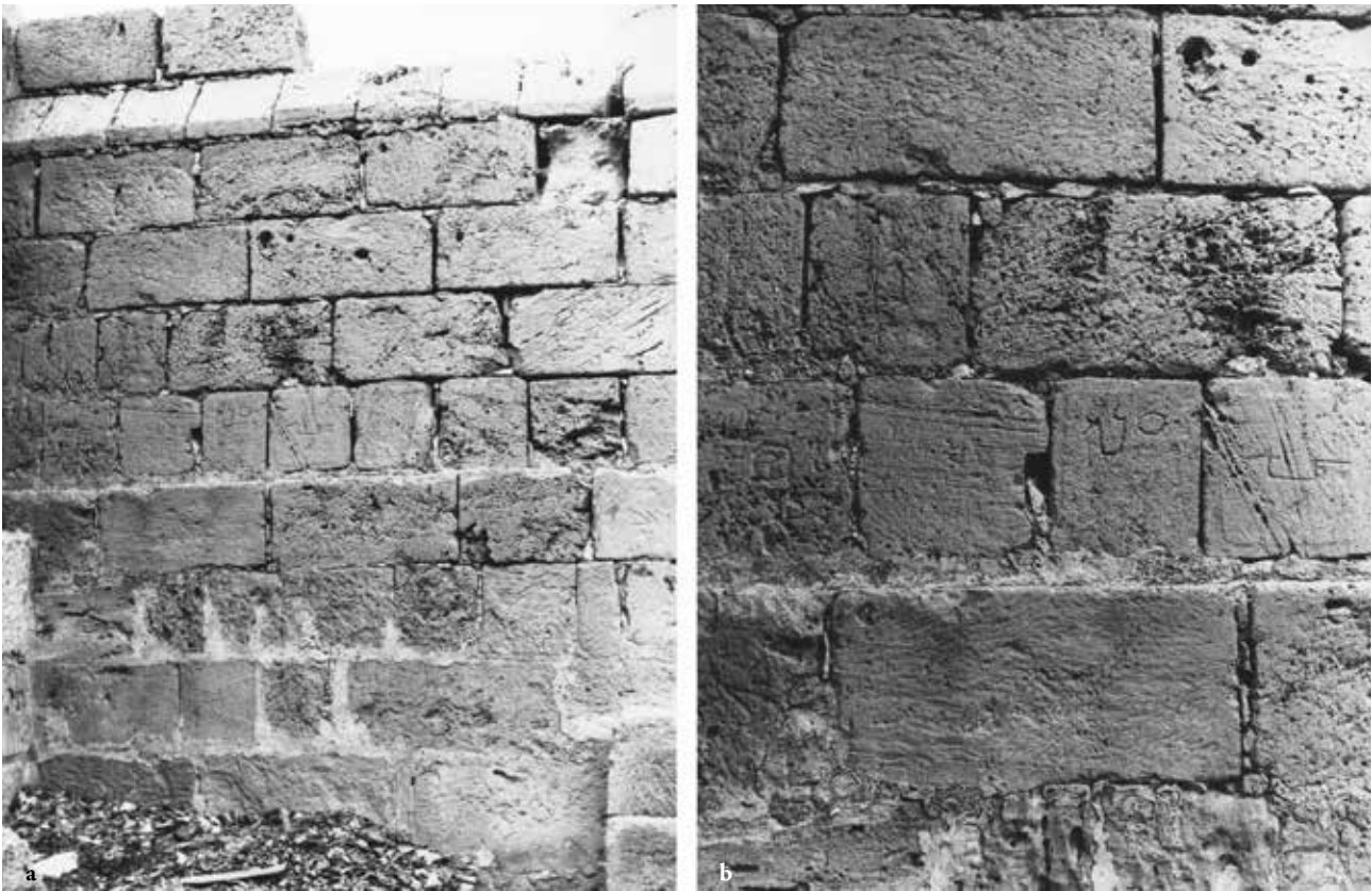
Fig. 20. Leptis Magna, Tempio di Roma e Augusto. Torre bizantina, muro nord-est: a) veduta della fronte nord-est; b) dettaglio dei marchi su due conci in arenaria, apparecchiati nel filare immediatamente al di sopra della risega (foto Solazzi, 1967; CAS, Fondo CNR, neg. nn. 582.002-003).
