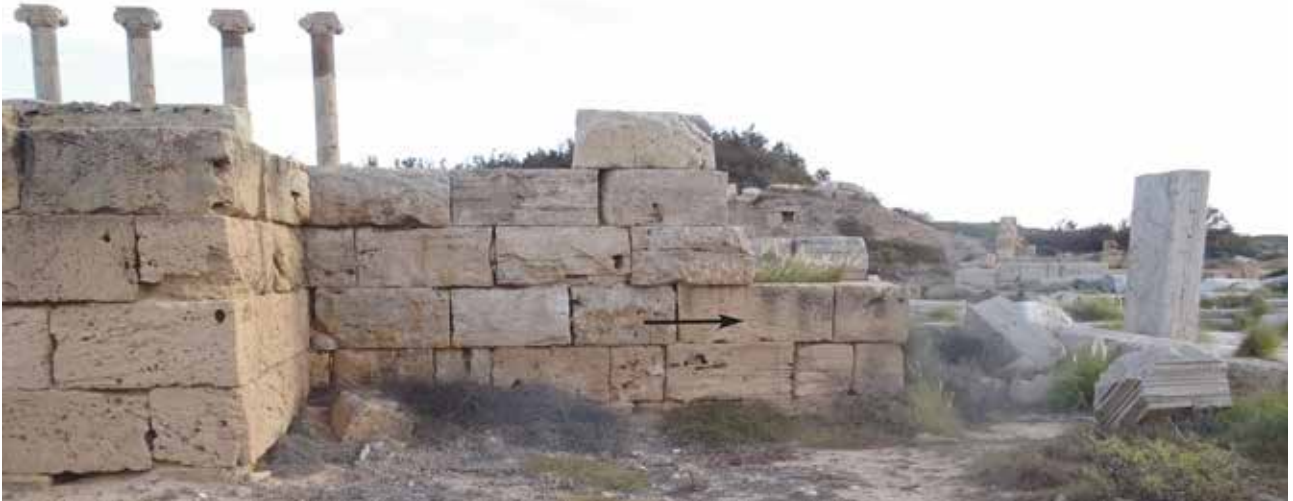
Fig. 27. Leptis Magna, Tempio di Roma e Augusto. Muro S109, veduta del prospetto sud-ovest, da Sud-Ovest (foto A., 2023).
