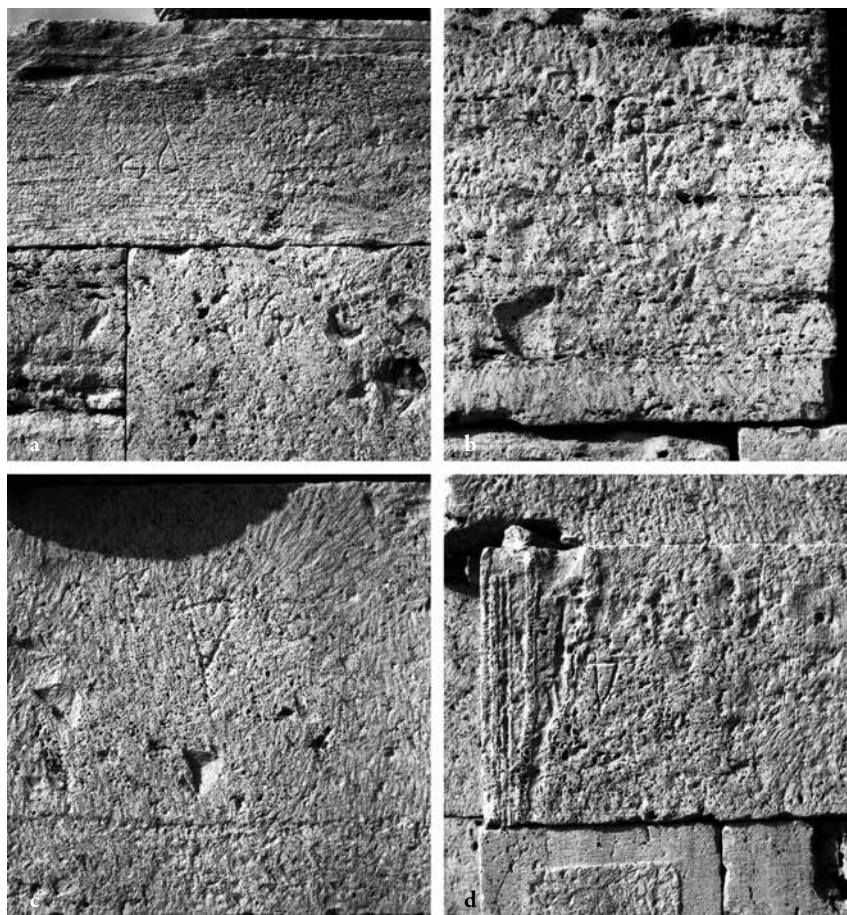
Fig. 16. Leptis Magna, Tempio di Roma e Augusto. Muro S107, vedute di alcuni marchi sulla superficie nord-est dei blocchi (foto Solazzi, 1967; CAS, Fondo CNR, neg. nn. 647.001, 646.001-002, 648.002).
