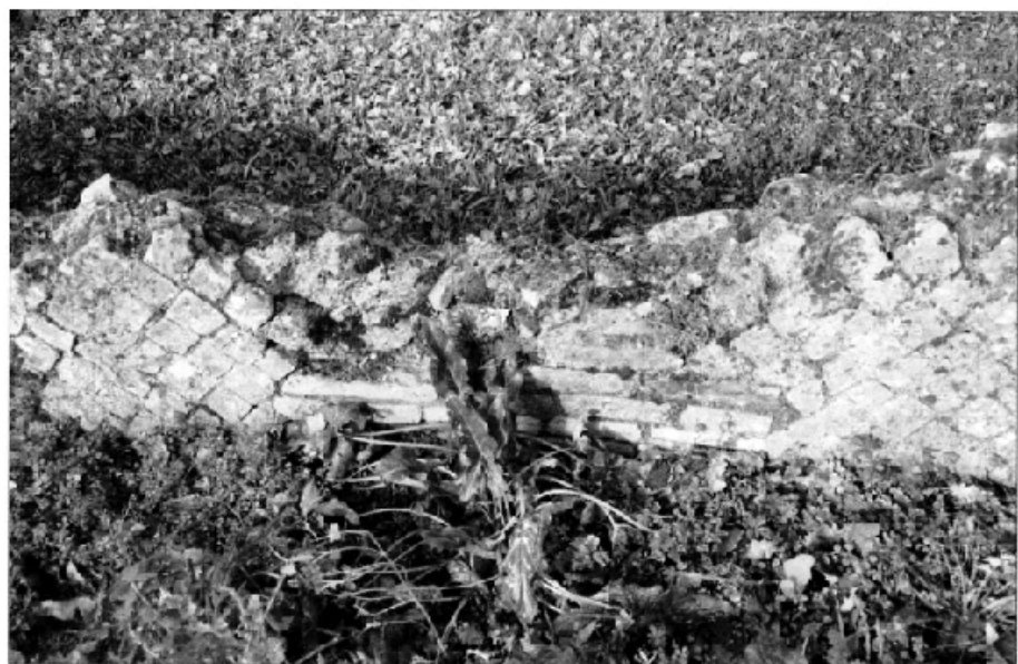
Fig. 7 - Falerone. Teatro. Paramento interno del muro del podio della scena, realizzato in opera reticolata e laterizi, particolare. Da Sud.
