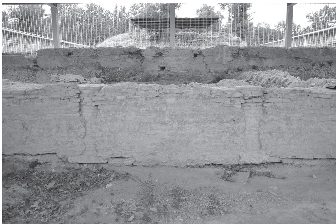
Fig. 41 - Criptoportico. Le due colonne che nella prima fase sottolineavano il passaggio tra il vestibolo e il braccio orientale del Criptoportico inglobate nella muratura di II fase. Si notino le lastre in calcare su cui poggiano le colonne. Da Est.
