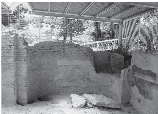
Fig. 47 - Vrbs Salvia. Criptoportico: l'abside settentrionale. Si noti l'impiego di una tecnica costruttiva mista che alterna ricorsi in laterizi ad un *opus quasi reticulatum*. Da Est.
