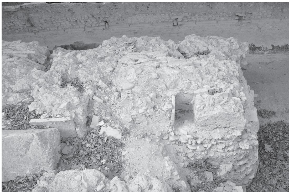
Fig. 51 - Criptoportico. Braccio Nord: i resti degli alloggiamenti delle travi pertinenti al solaio per il pavimento del livello superiore visibili nel crollo del muro perimetrale meridionale. Da Sud.
