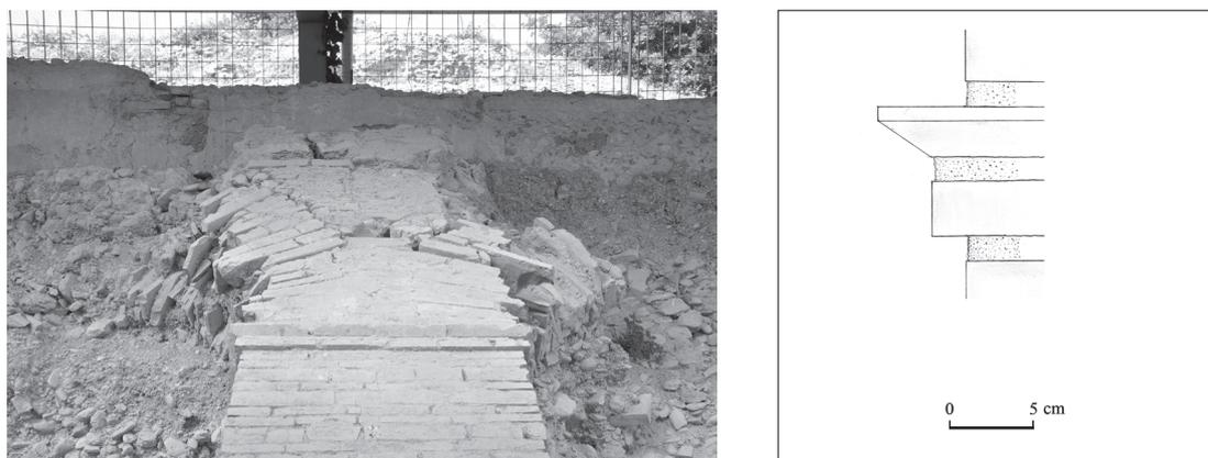
Fig. 44 a e b - Criptoportico. Braccio Sud: particolare della cornice del pilastro 7. Da Sud. Rilievo, profilo della cornice in scala 1:5.
